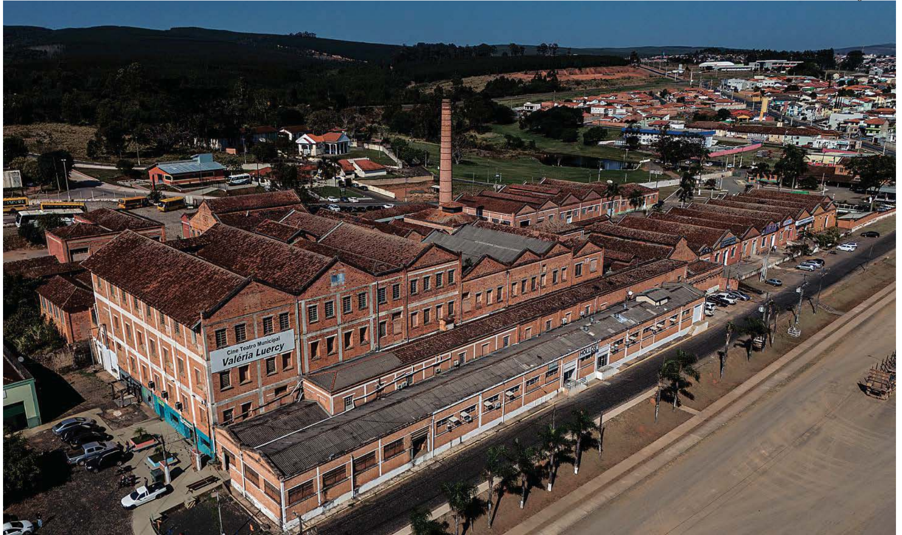
Complexo Industrial do conde Francesco Matarazzo começou a funcionar plenamente em 1924, em Jaguariaíva, nos Campos Gerais
